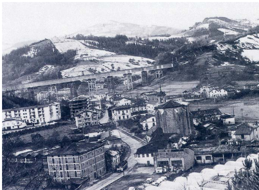
El crecimiento de IRIZAR exigió a construcción y edificación de una nueva nave de producción en Ormaiztegui. En la imagen, en primer plano, el tejado del nuevo pabellón, con Ormaiztegui al fondo.
